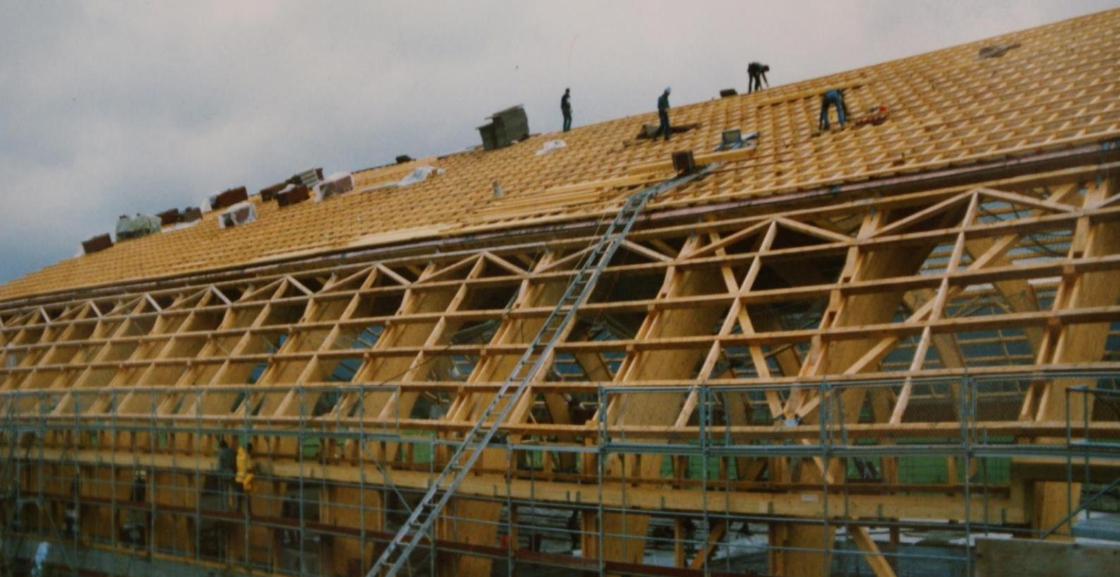
Patinoire du Bugnon des Ponts-de-Martel, montage et mise en place de la charpente de la toiture Nord en été 1988
